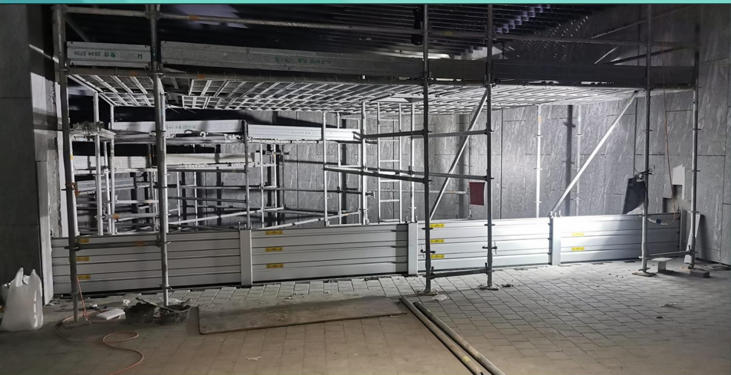
用於 寬闊的汽車坡道 (正在建設中)
